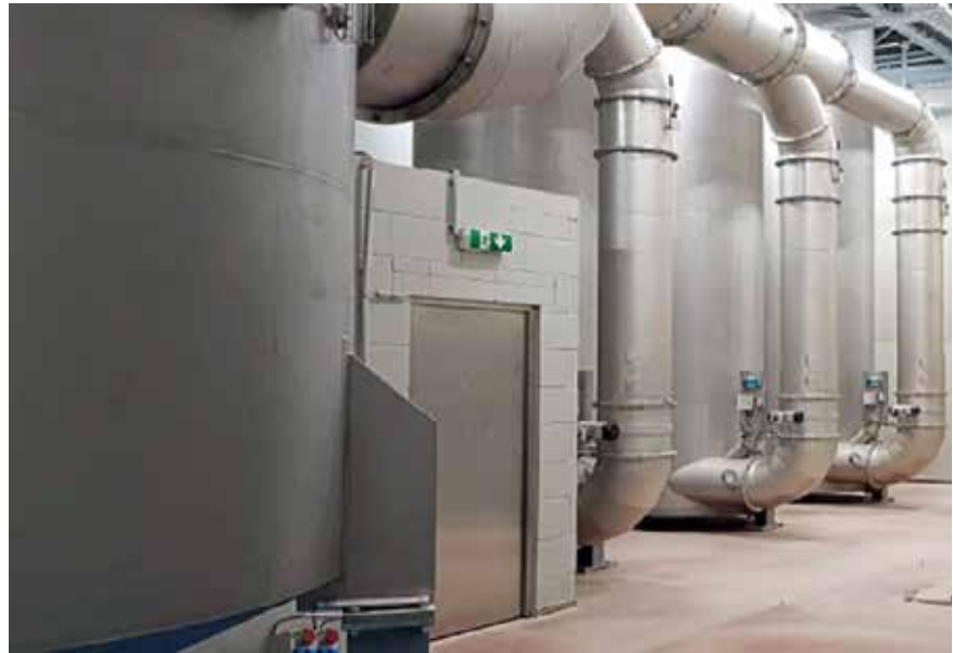
Die drei KMA Elektrofilter (rechts) und der Gaswäscher (vorne links) sorgen für eine Reinluftqualität gemäß TA Luft.
